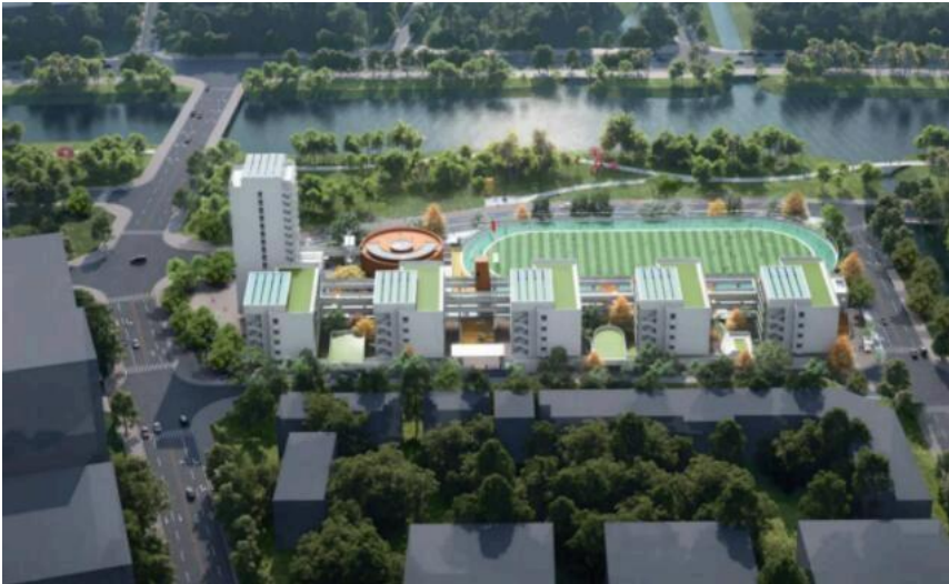
新校已于2024年9月获取施工许可证，正在全力推进建设中。
